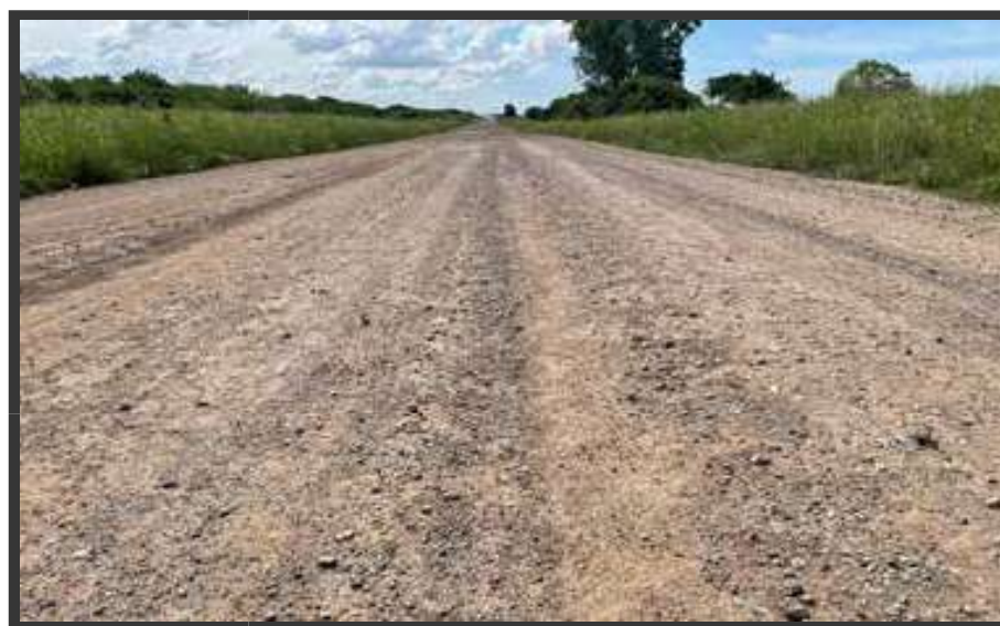
Ruta Provincial 1001 - 50 km de reciclado con incorporación de cal y escoriado superficial.
