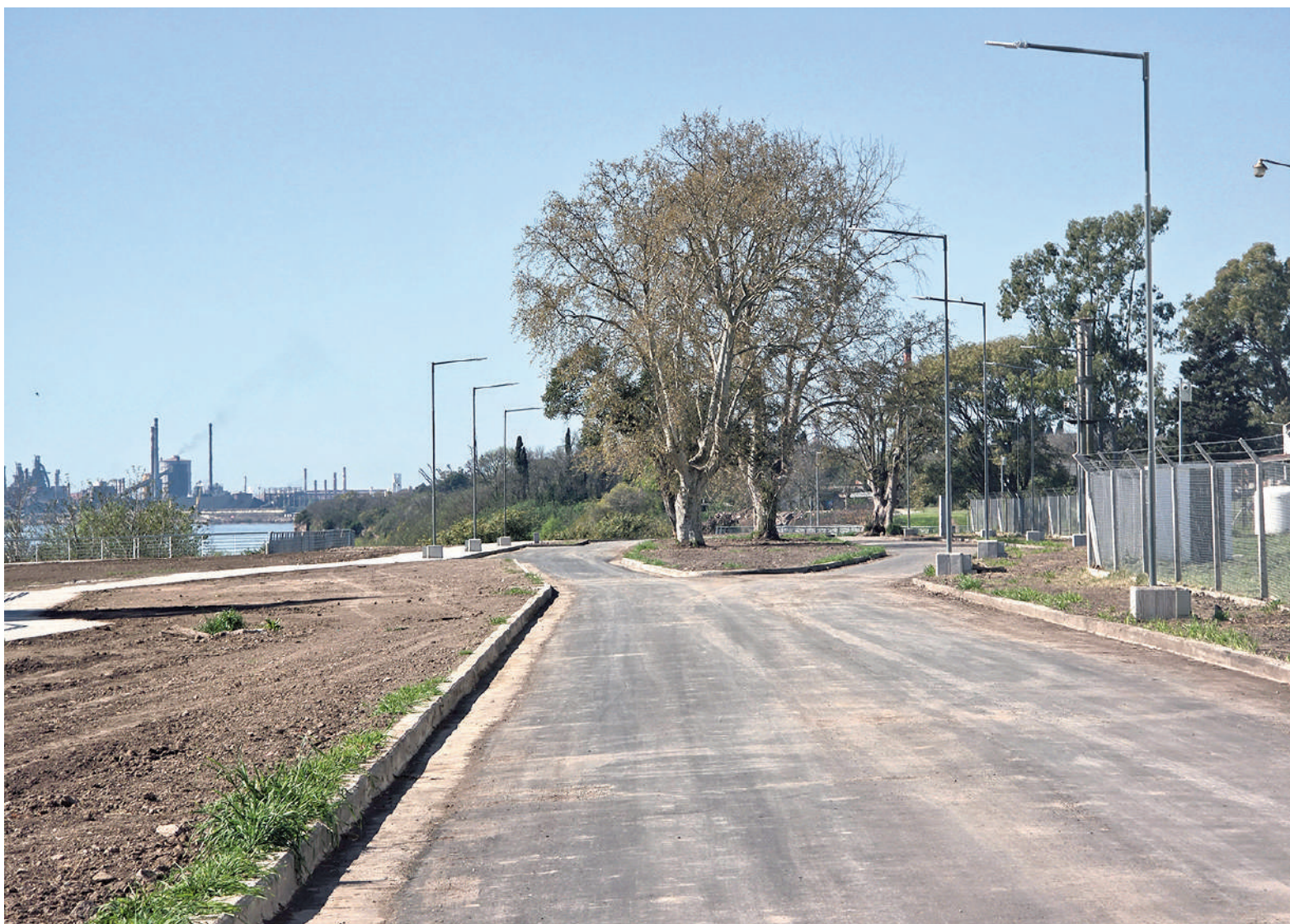
El cordón cuneta y el pavimento del tramo final de la Avenida del Río ya están concluidos y ahora trabajan en el parquizado adyacente. EL NORTE
