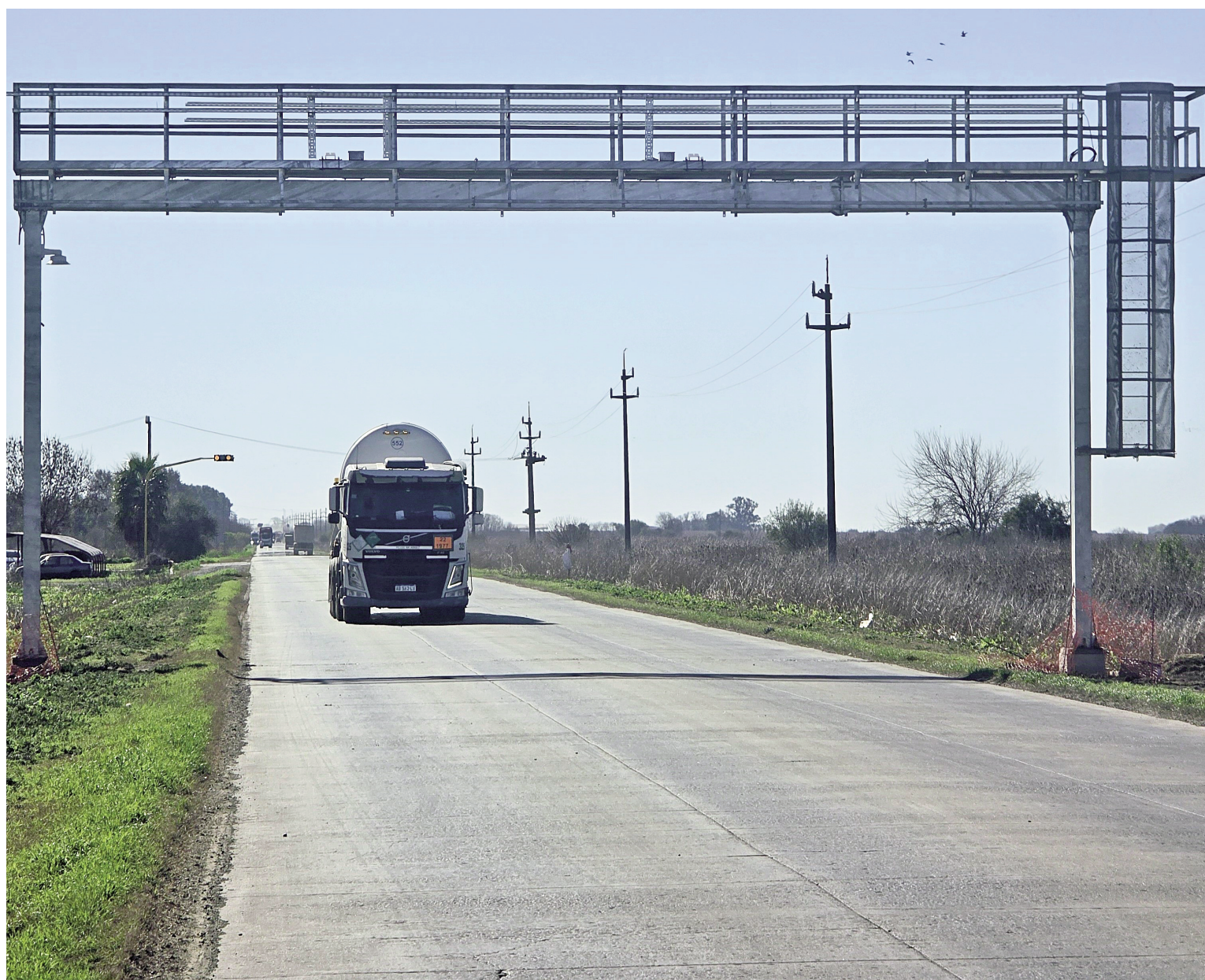
PÓRTICO DE PEAJE. Transportistas indican que sus empresas deberían tributar entre $100 millones y $500 millones al año. FOTO EL NORTE
