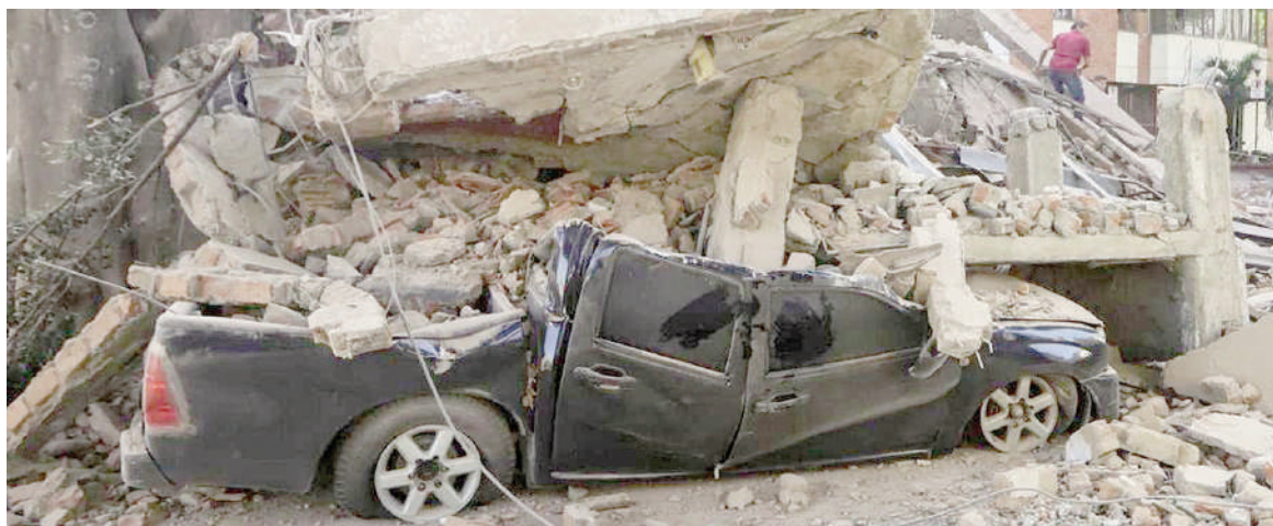
Residentes y equipos de rescate buscan entre los escombros tras el terremoto.
