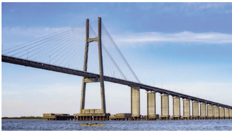
Quedó rehabilitado el puente Rosario-Victoria.
