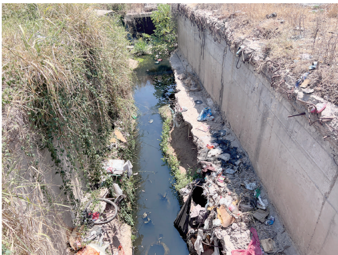
El zanjón San Nicolás es un desagüe de vital importancia para el escurrimiento del agua en la zona sur de la ciudad.
