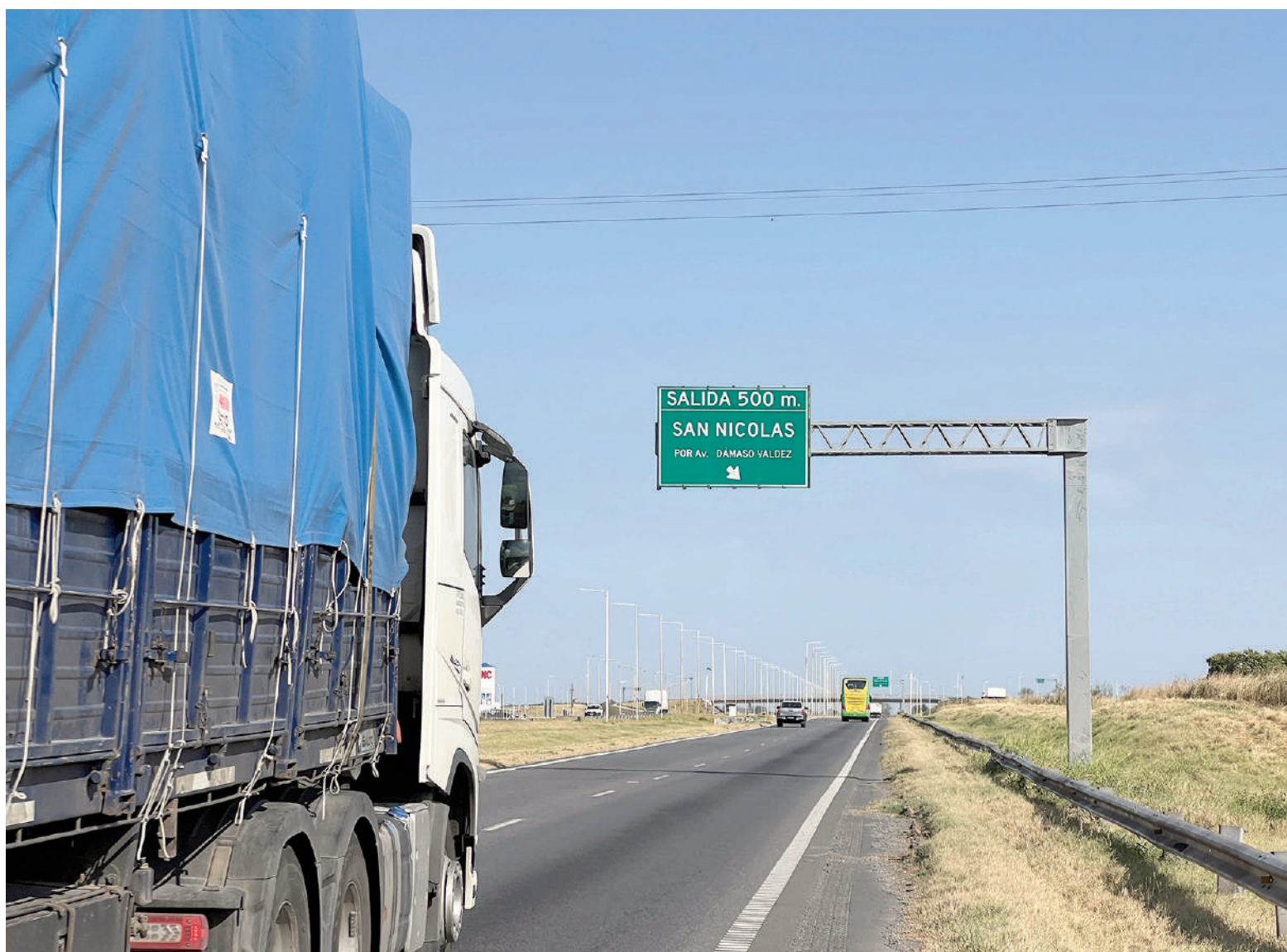
El tramo vial a concesionar incluye el segmento de la Ruta 9 que se extiende entre Campana y el Arroyo del Medio. ARCHIVO / EL NORTE
