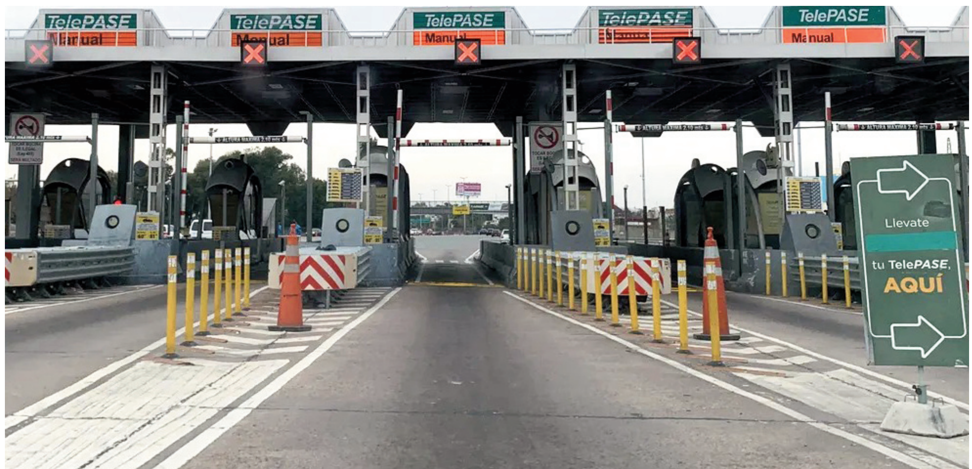
Sobre la ruta 9, las próximas cabinas de peaje se instalarían a la altura del kilómetro 195, en la localidad de El Paraíso (partido de Ramallo).
