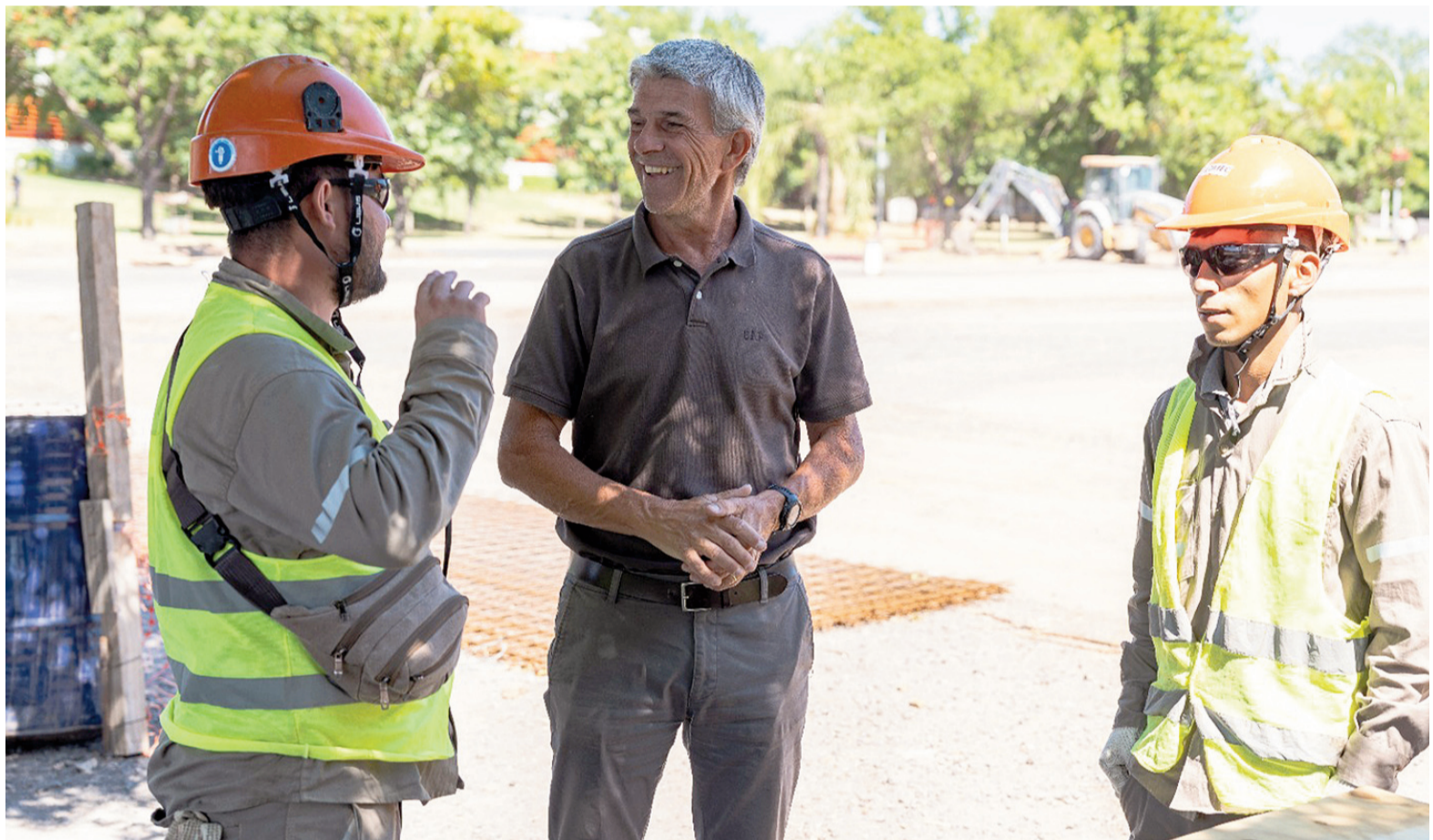
El intendente interino Daniel Luchelli recorrió el lugar y supervisó el avance de los trabajos.
