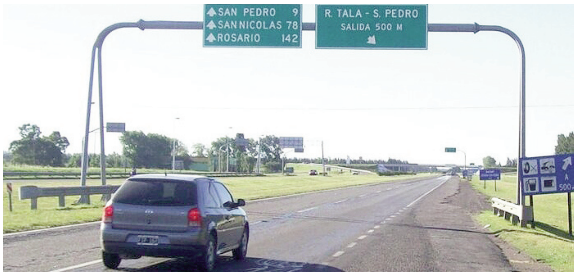
El Portuario Sur, con extensiones de las rutas 9 y 188, es uno de los doce tramos incluidos en la Etapa II de la Red Federal de Concesiones Viales.
