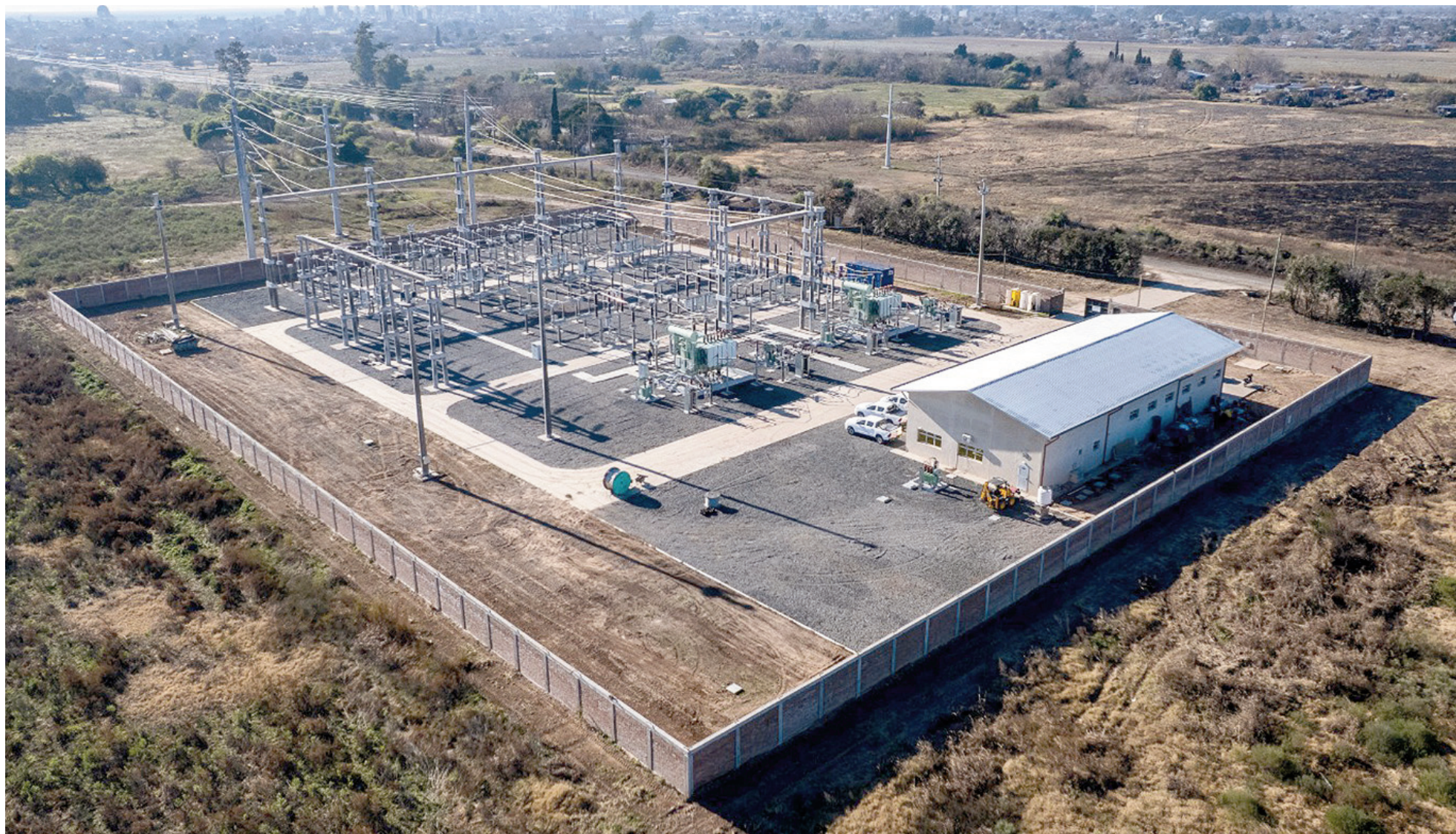
La obra corresponde a la construcción de un nuevo alimentador de 13,2 kV, que se inicia en la Estación Transformadora San Nicolás Norte.
