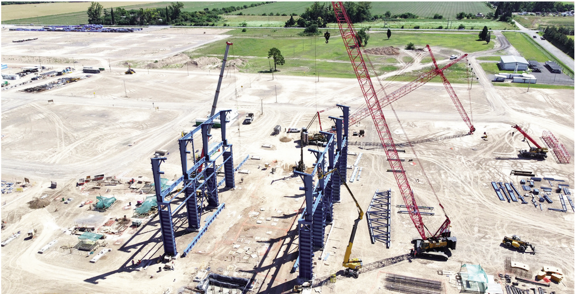
Sidersa inició el 31 de julio pasado la construcción de una planta siderúrgica de última generación en San Nicolás.
