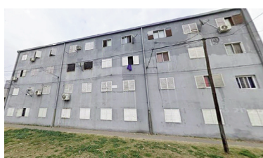
Edificio de donde cayó el menor.
