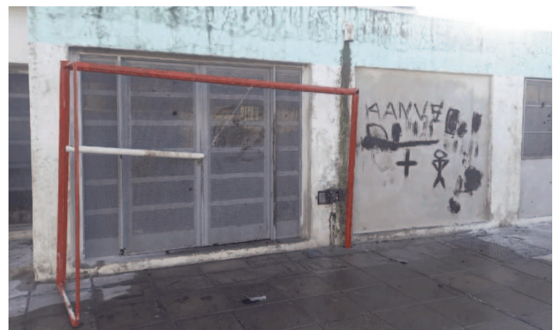
La Primaria 46, tras la agresión al edificio sufrida este fin de semana.
