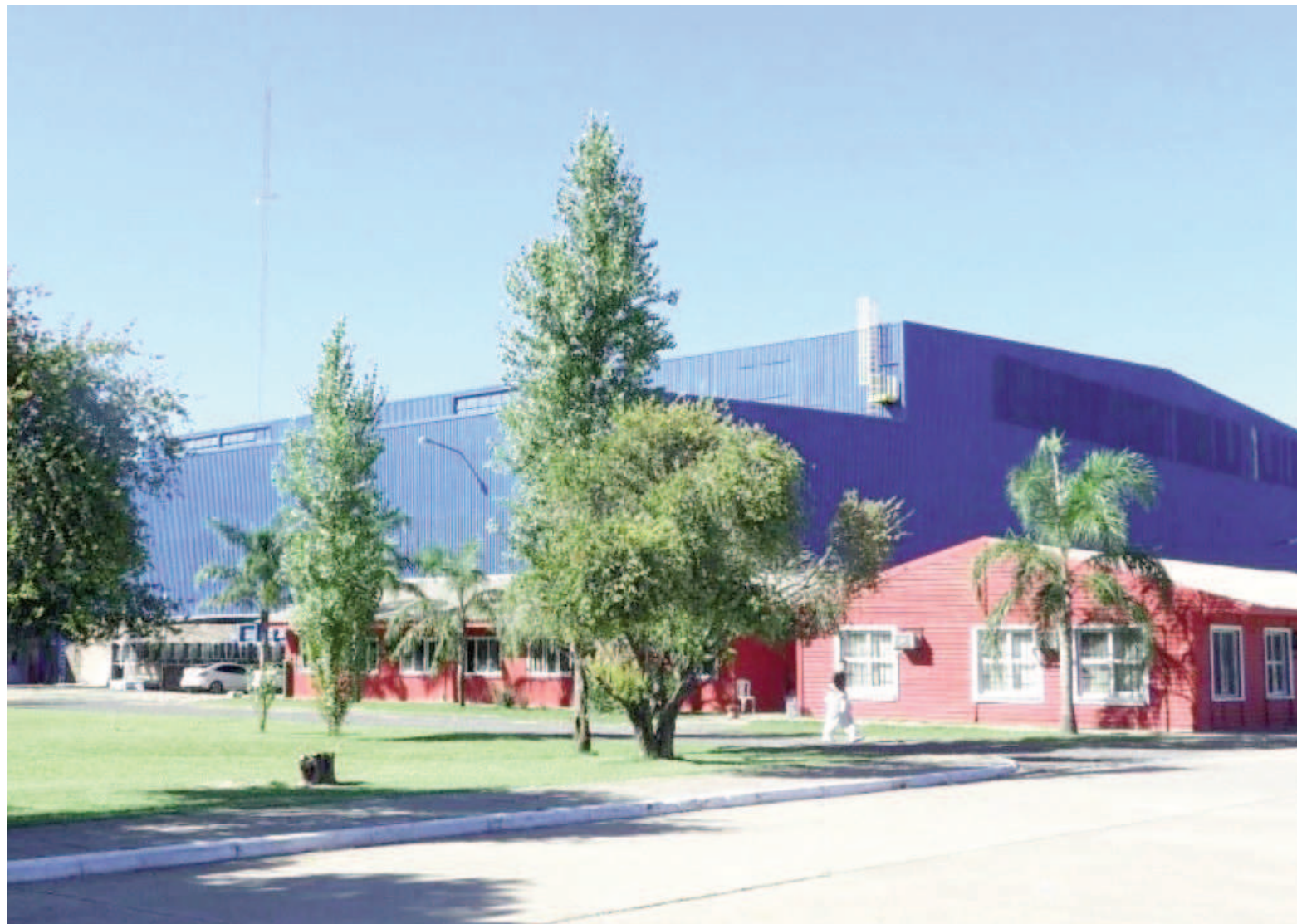
La planta de Laboratorios Ramallo está clausurada desde el 6 de mayo pasado en el parque industrial Comirsa. ARCHIVO / EL NORTE
