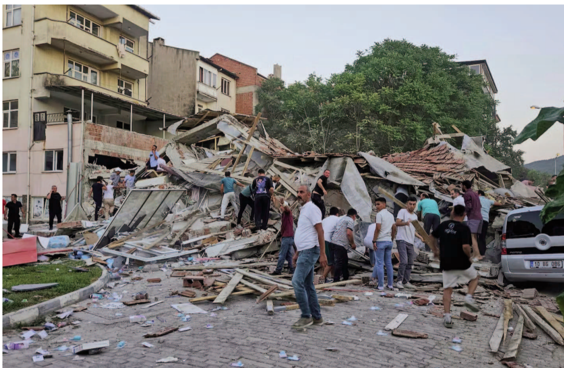
Un edificio derrumbado tras el terremoto en Sındırgı, noroeste de Turquía.
