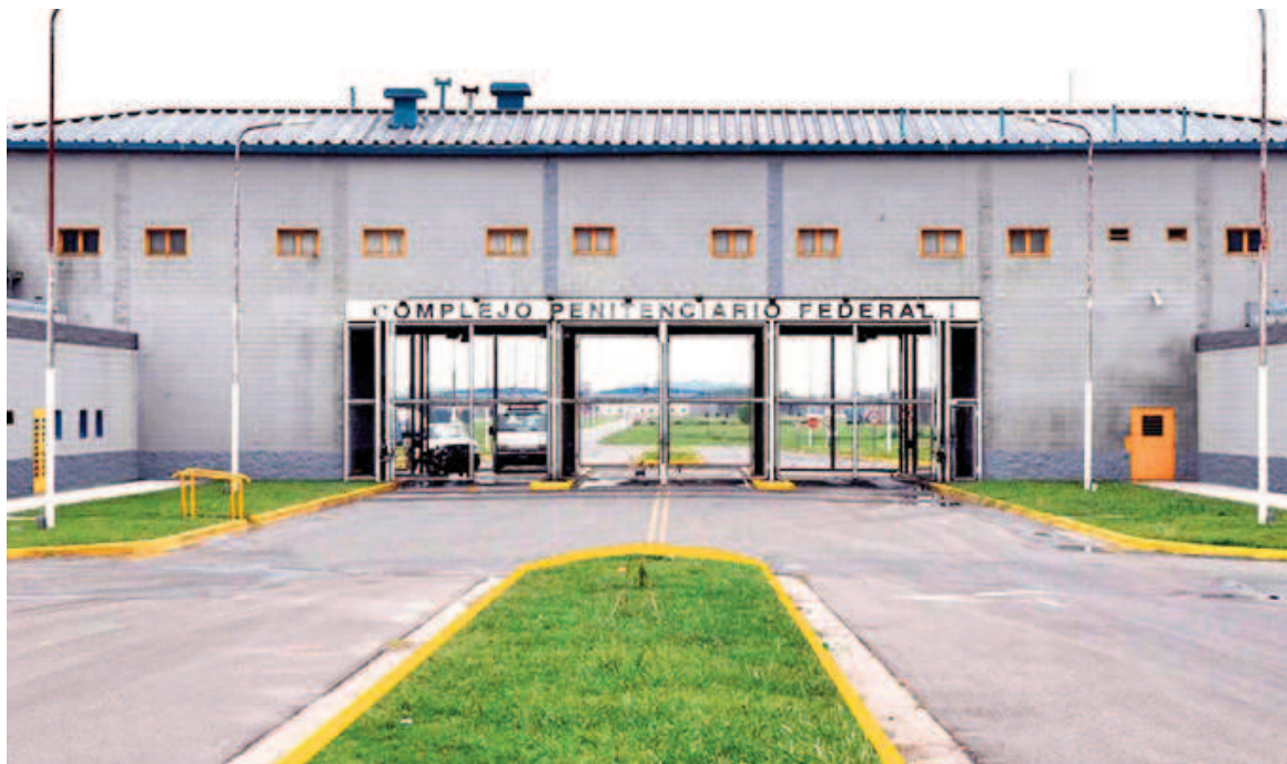
Complejo Penitenciario Federal N° 1 de Ezeiza.
