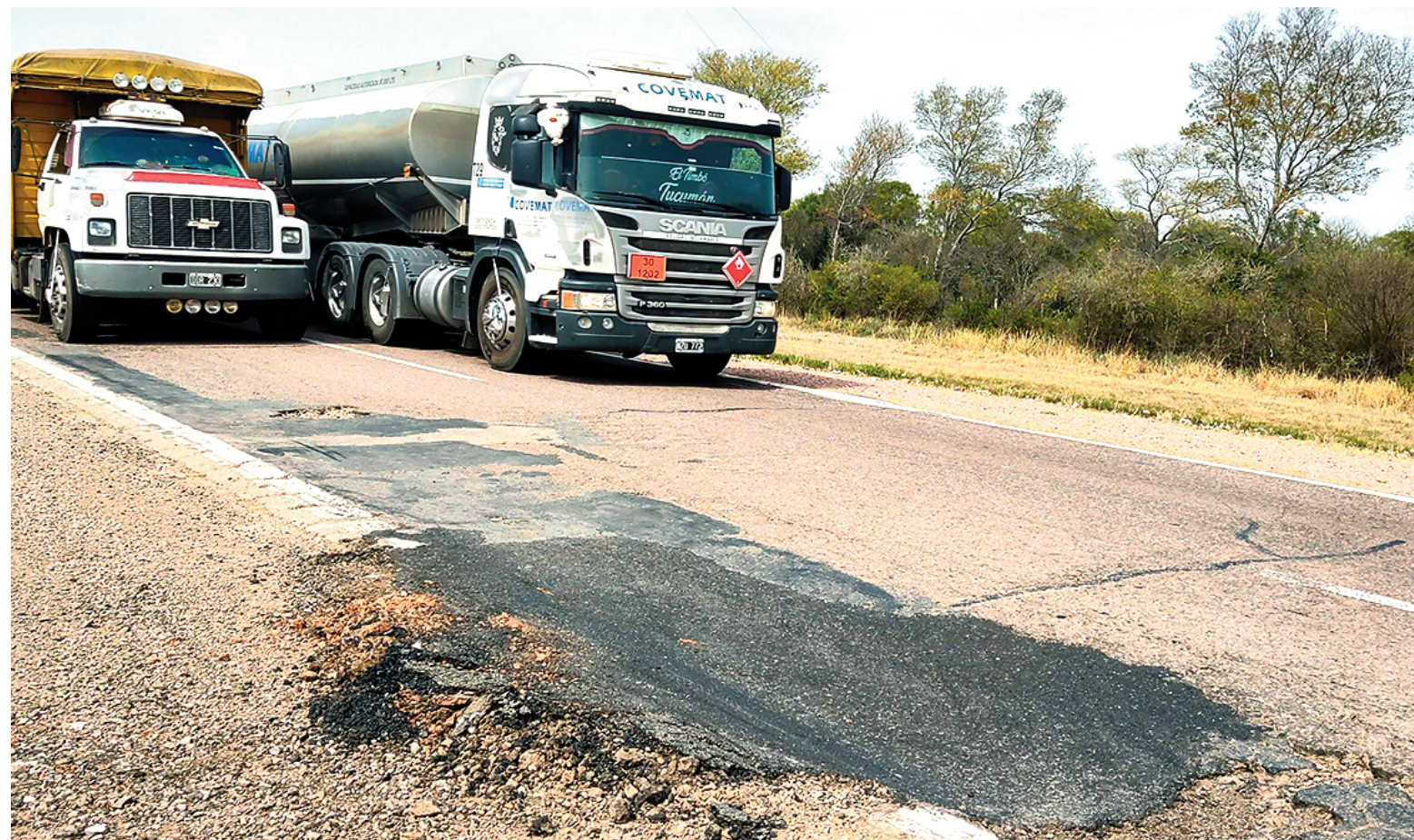
● TRANSPORTISTAS EN ALERTA POR EL PROGRESIVO DETERIORO DE LAS RUTAS NACIONALES
