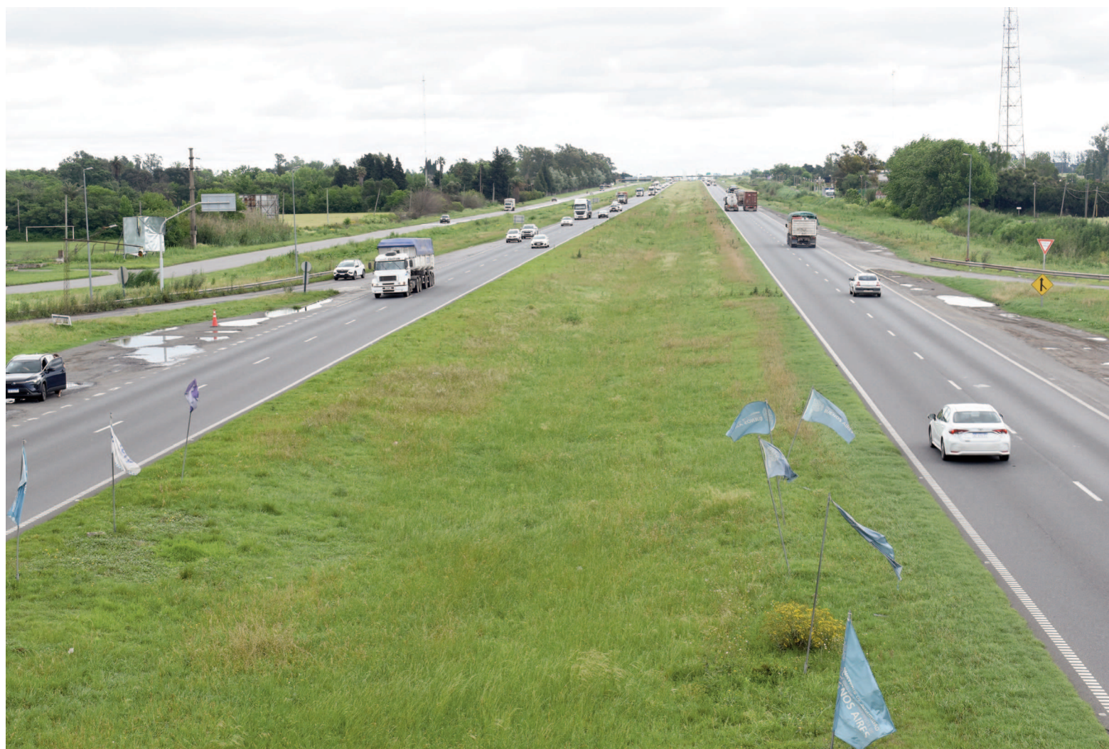
Entre los tramos a licitar y concesionar estarán los 164 kilómetros de la Ruta 9 que se extienden entre Campana y el Arroyo del Medio. ARCHIVO / EL NORTE
