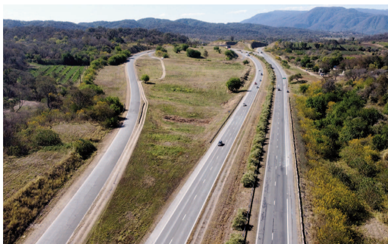
Se avanza en el cierre de Corredores Viales.
