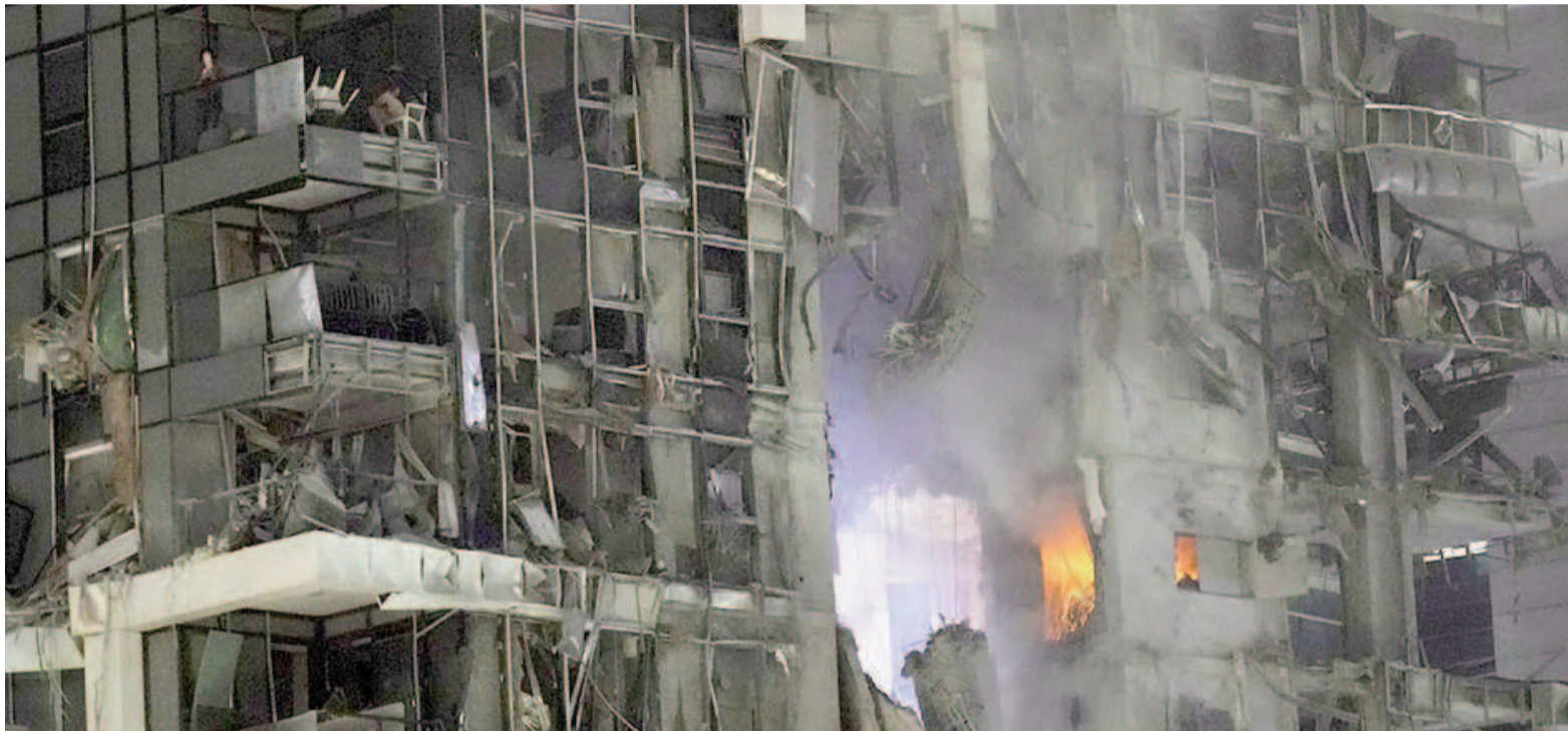
Un edificio destruido por el bombardeo de Irán en Tel Aviv. FOTO AP
