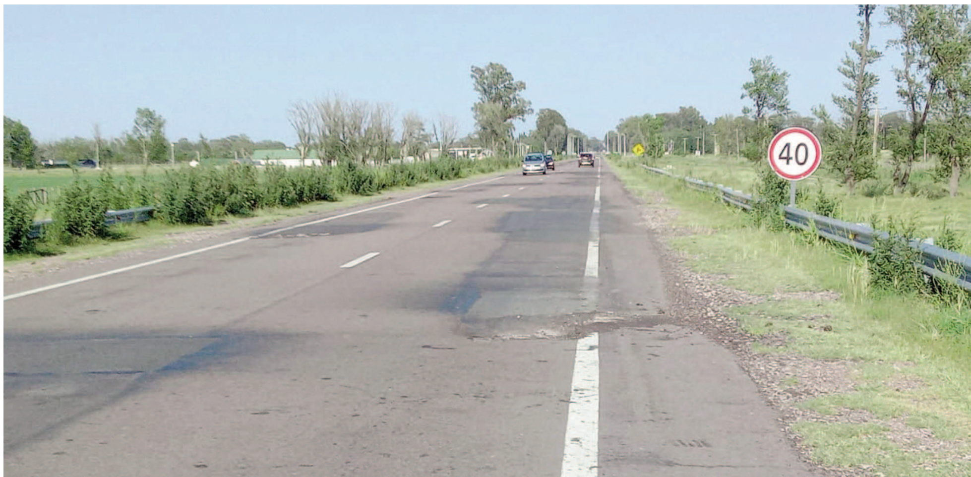
Están contempladas las privatizaciones de segmentos de las rutas 188 y 9 que atraviesan el Partido de San Nicolás.
