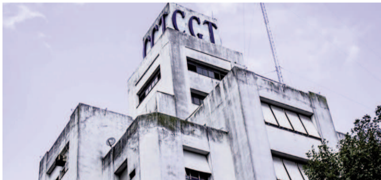
Edificio central de la CGT en Azopardo 802.
