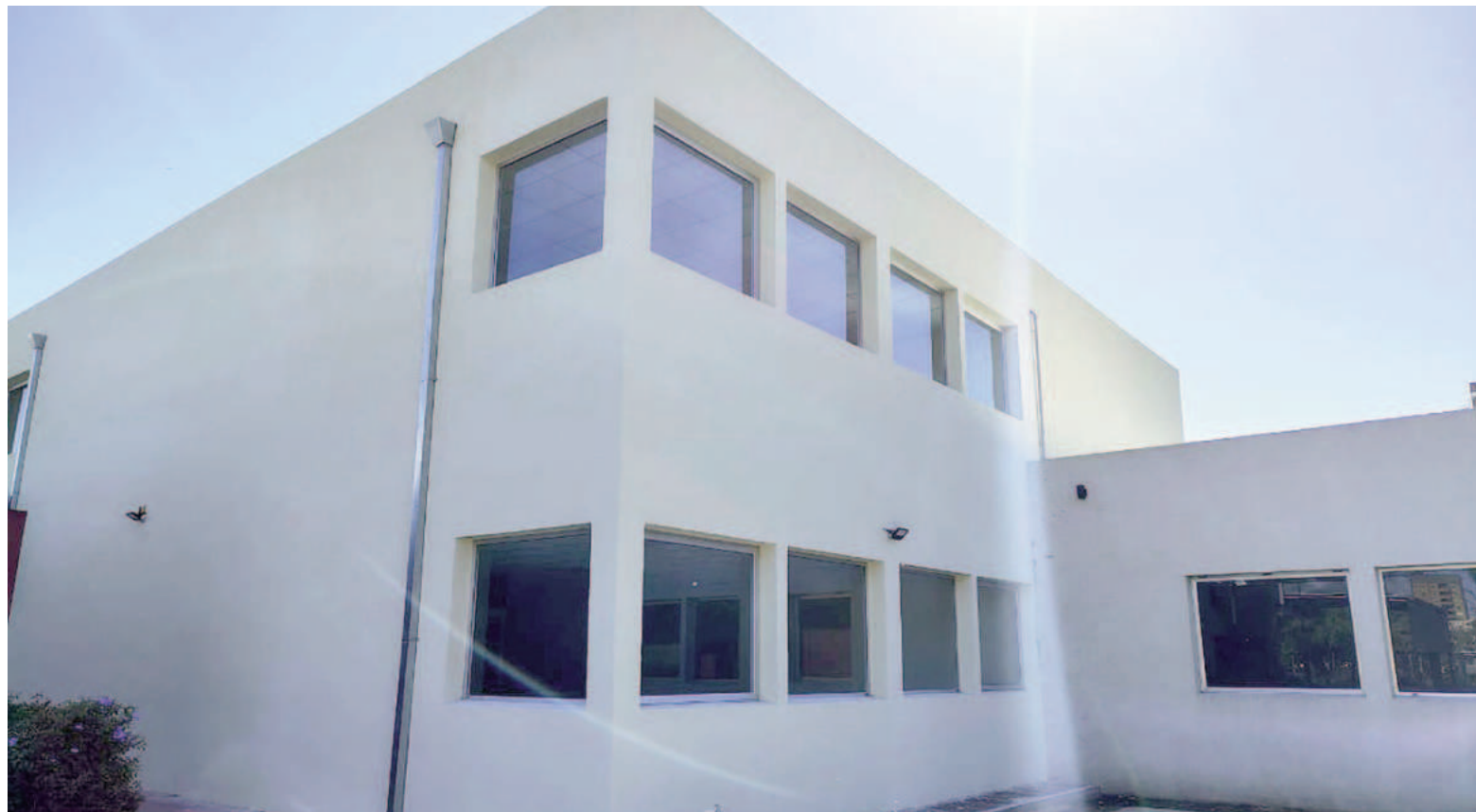
La obra se inició en julio de 2024 y finalizó en febrero de este año, con una superficie total construida de 962,50m 2 .
