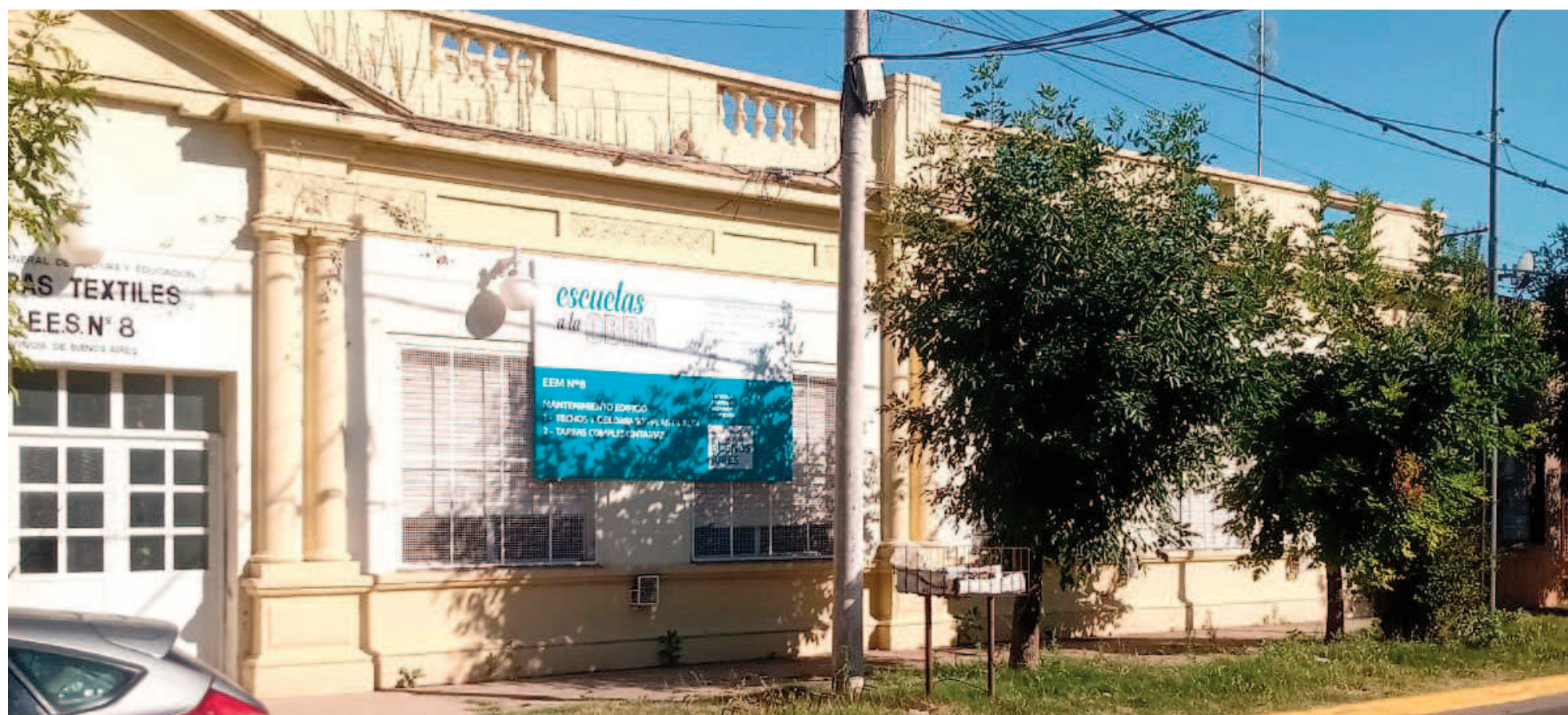
En la Secundaria de La Emilia se trabaja sobre techos y cielorrasos de la planta alta y tareas complementarias.
