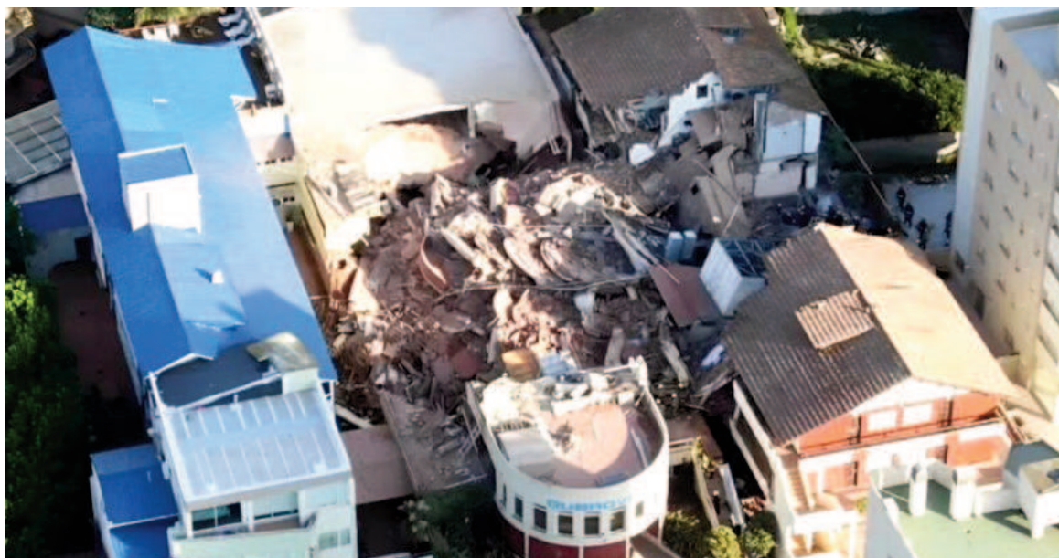
Vista aérea del colapso del Hotel Dubrovnik.
