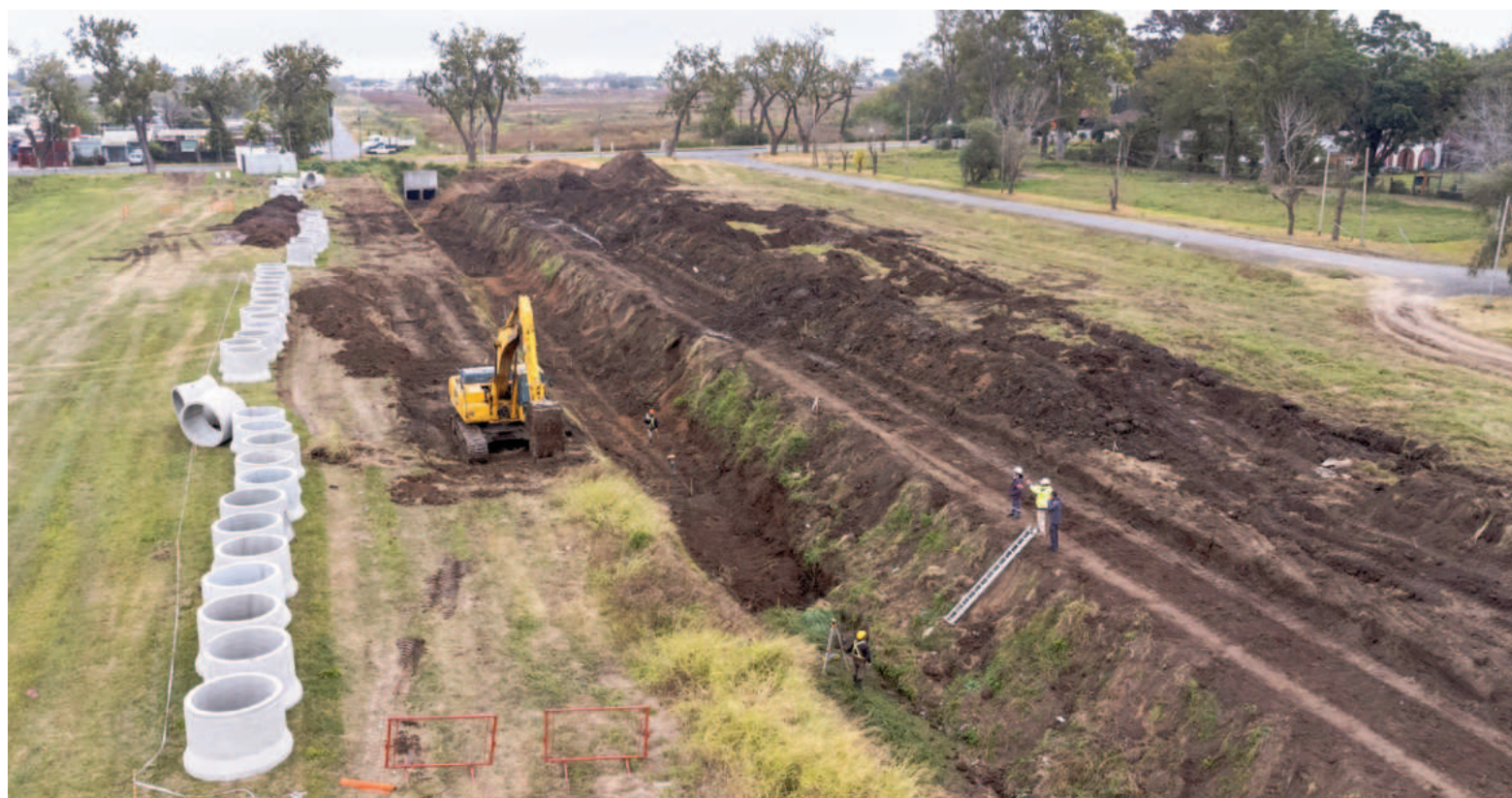
"Sin los 75 kilómetros de zanjones que hicimos, se hubieran inundado más de diez barrios", señaló el intendente. ARCHIVO
