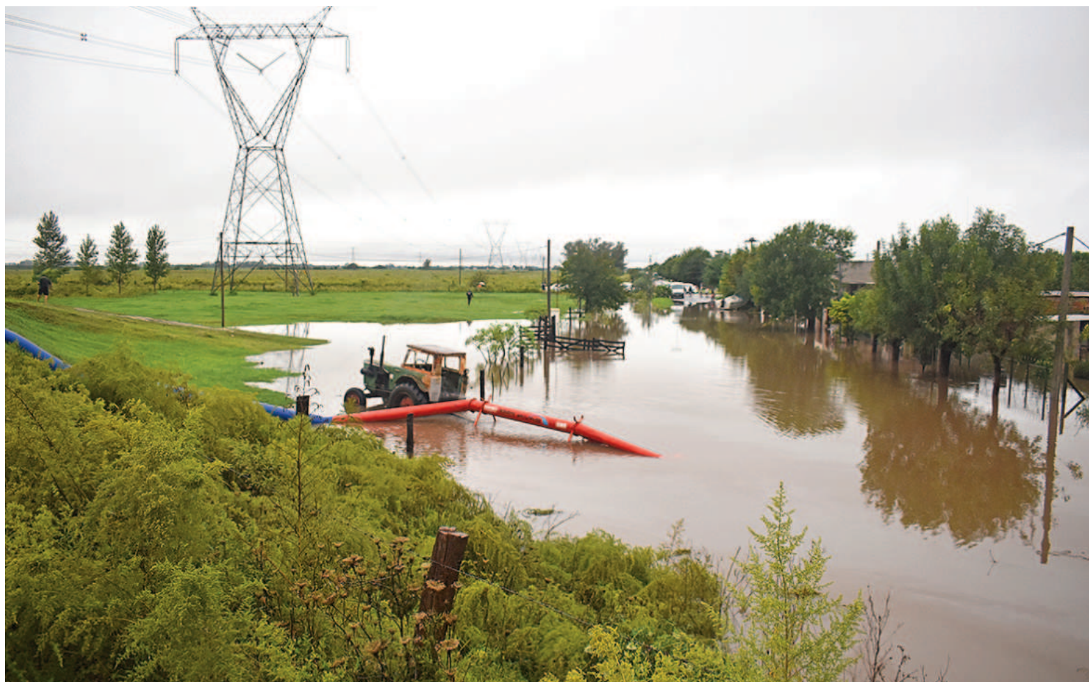
El terraplén y la estación de bombeo constituyen protecciones hidráulicas decisivas para La Emilia, históricamente expuesta a los desbordes del Arroyo del Medio.
