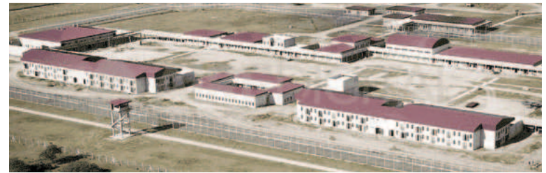
El complejo federal se encuentra en un 90% de ejecución.
