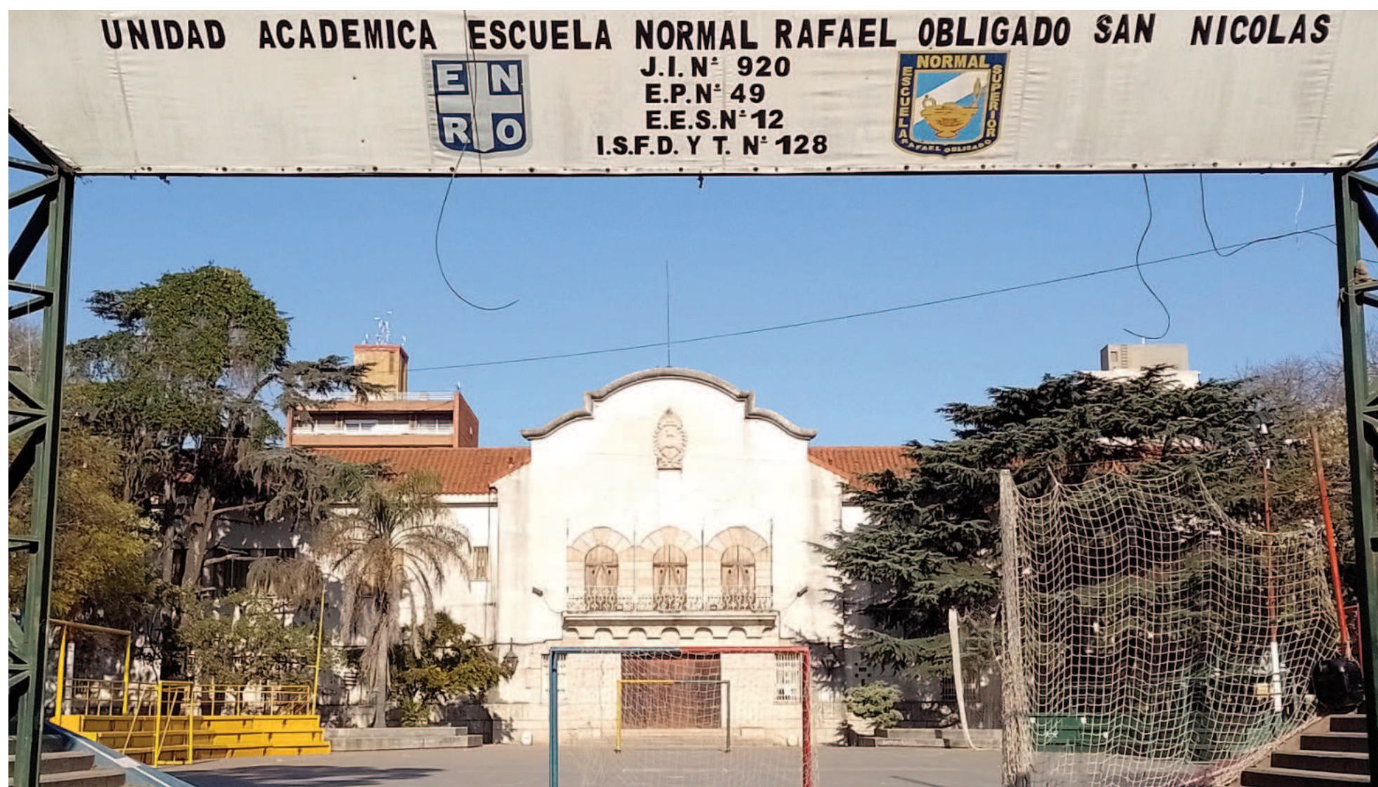
Desde la Dirección Provincial de Infraestructura indicaron a este medio que la obra del gimnasio asciende a 54 millones de pesos mientras que la de la cubierta, a 109 millones. EL NORTE
