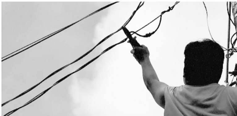
Daños materiales. El robo de cables crece en la región. - DIB -
