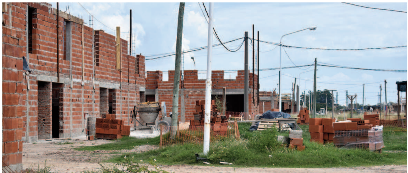
La decisión de las actuales autoridades nacionales de frenar la obra pública derivó en la paralización de los trabajos, a mediados de enero de 2024. FOTO: IARA CERASI/EL NORTE
